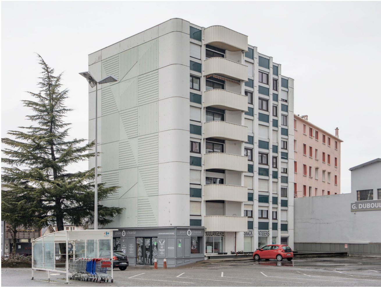
431 m alt Thonon-les-Bains, Atelier Recherche et Architecture, 1971-1973
