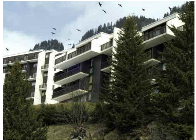
Façades rénovées à Flaine Forêt (R. Bianchi/CAUE 74)
