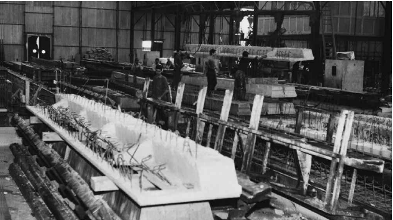
Usine de préfabrication, éléments de plafonds et poutrelles (© G. Carrard et M. Vardon/Centre Pompidou)
