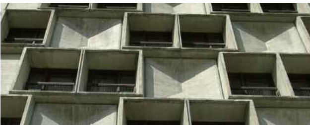
1, 2 & 3 : Hôtel Les Lindars, détails des fenêtres à coissons et panneaux en pointe de diamant. (G. Coquard/CCF)
