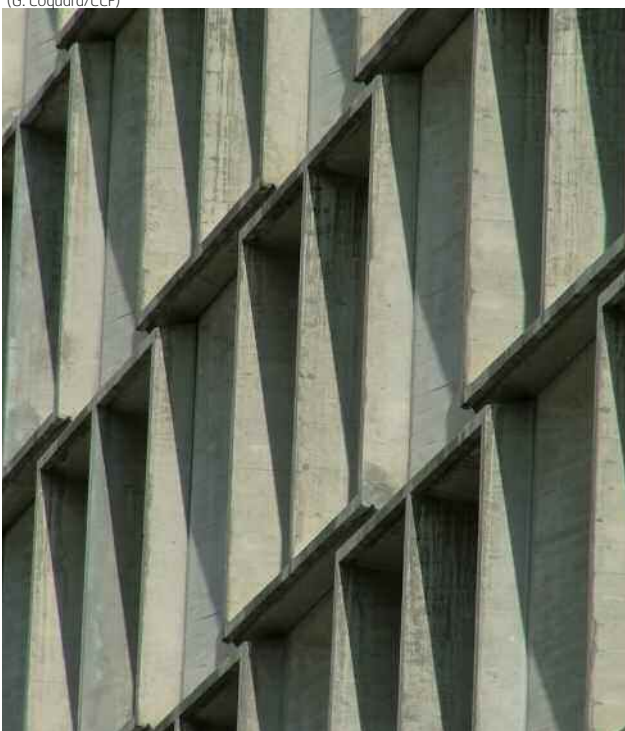
1, 2 & 3 : Hôtel Les Lindars, détails des fenêtres à coissons et panneaux en pointe de diamant. (G. Coquard/CCF)
