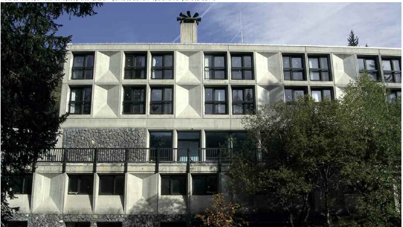
Hôtel Le Totem, panneaux de façade préfabriqués en « pointe de diamant », parement en pierre (CAUE 74)
