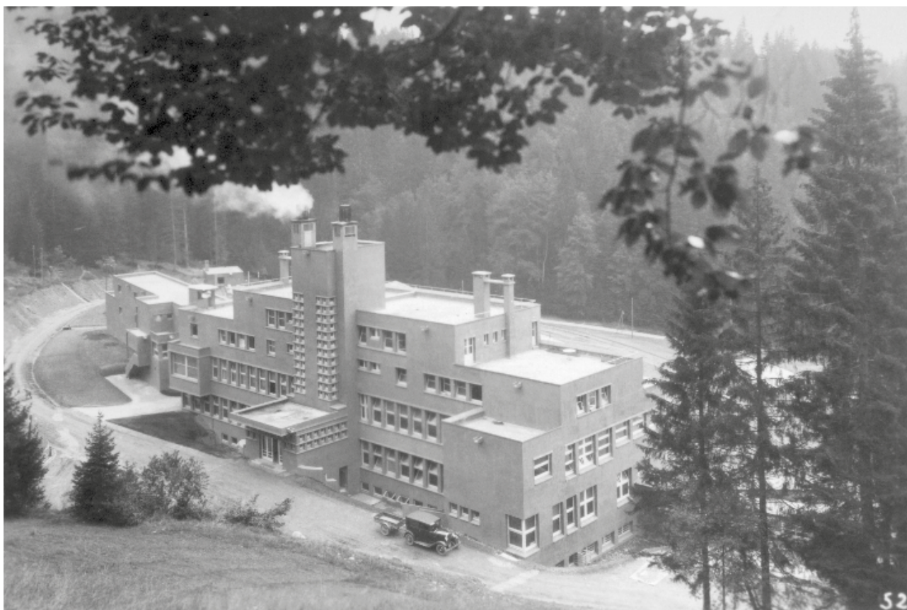
Façade nord du sanatorium Le Roc des Fiz, années 1930. AD74/142J903
