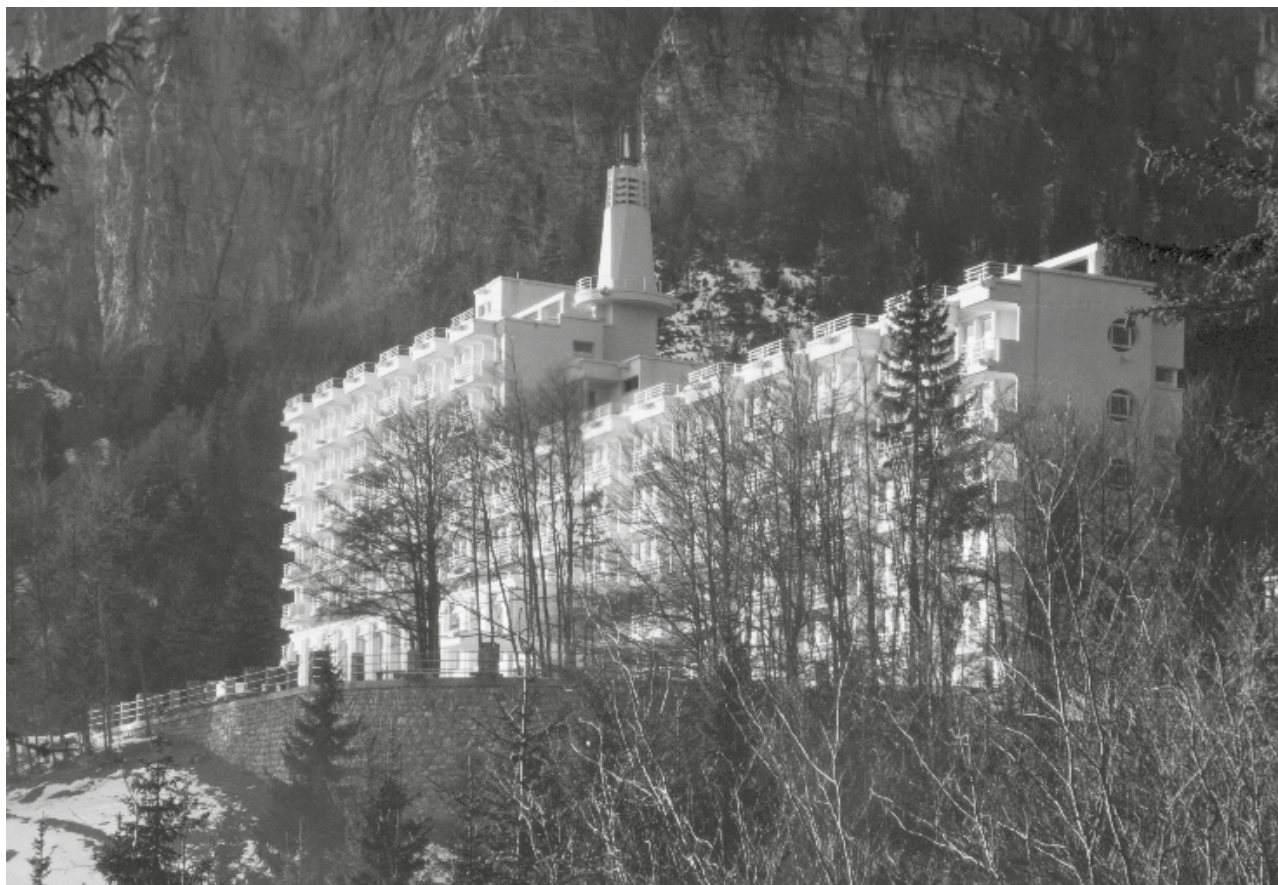
Sanatorium Martel de Janville au plateau d'Assy, édifié sur le modèle architectural de type suisse. AD74/142J1025
