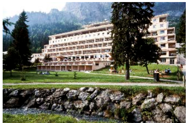
La façade principale (sud) du sanatorium Guébriant. Cliché P. Lemaître
