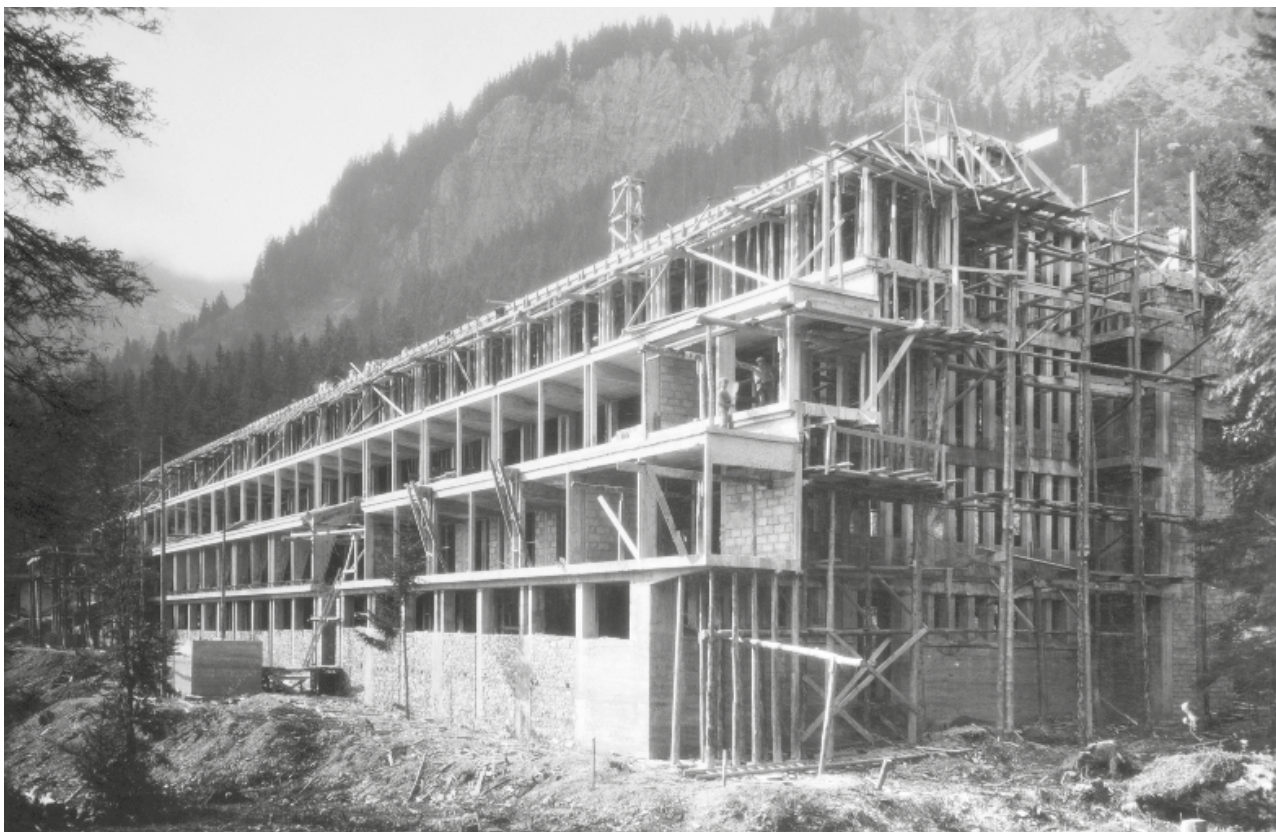
Sanatorium Guébriant en construction au début des années 1930. AD74/142J933
