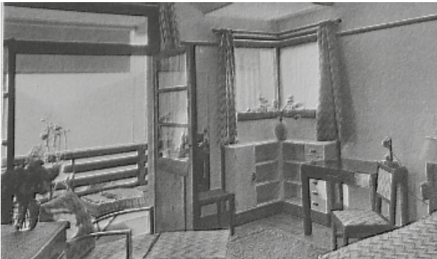
Une chambre de l'hôtel de cure L'Hermitage avec galerie de cure et fenêtre d'angle. AD74/142/816
