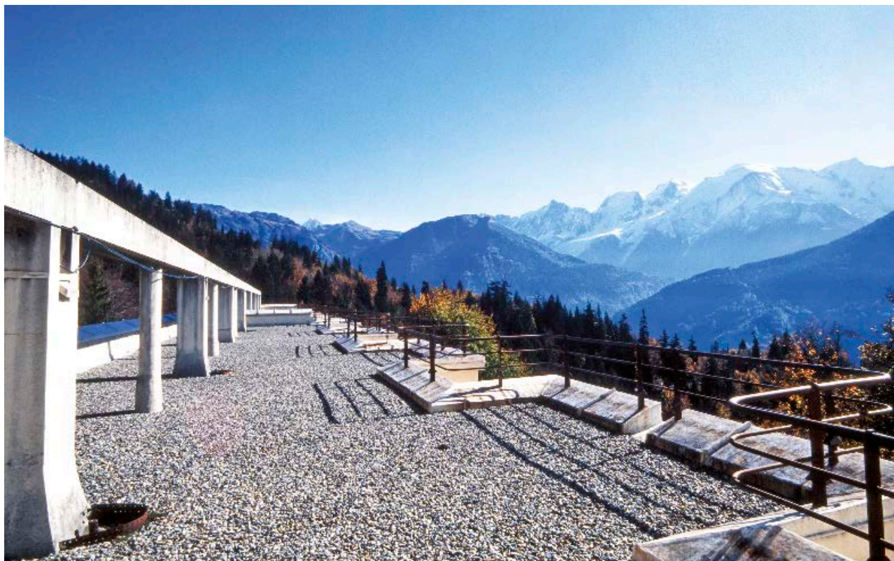
La chaîne du Mont-Blanc vue depuis la toiture terrasse du sanatorium Martel de Janville. Cliché P. Lemaître
