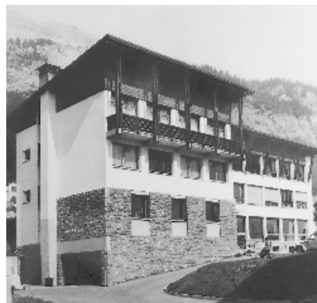
Centre d'ergothérapie pour l'Association pour le développement des activités culturelles et ergothérapeutiques du plateau d'Assy, H. J. Le Mème architecte, fin des années 1960. AD74/142/3377
