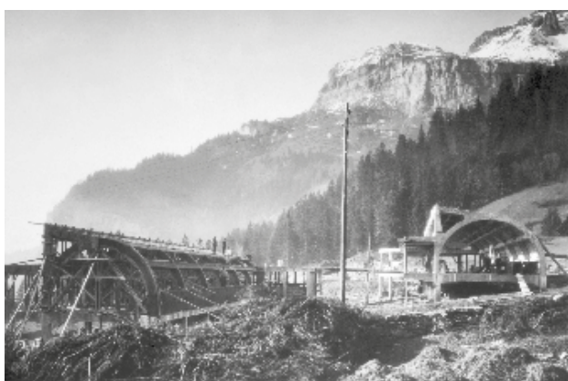
Chantier du sanatorium du Roc des Fiz au début des années 1930. AD74 / 142J903
