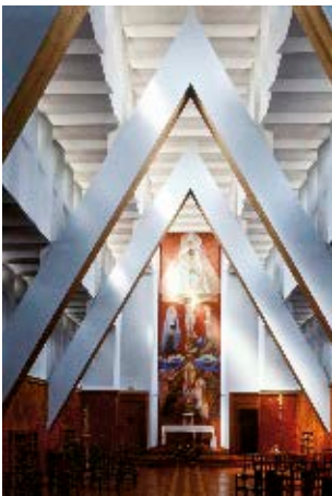
La chapelle du sanatorium Martel de Janville et son plafond à gradins soutenu par trois arbalétriers triangulaires. Clichés P. Lemaître
