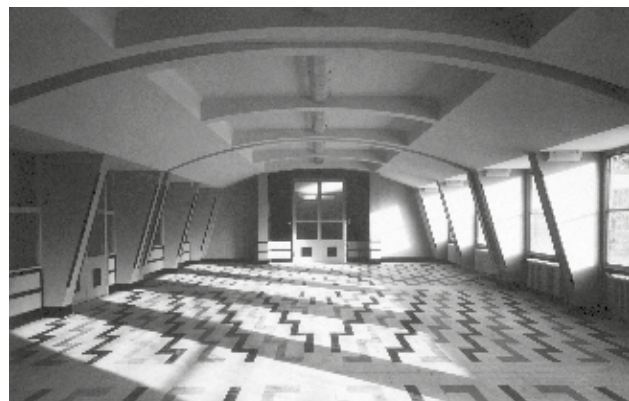
La salle à manger du sanatorium Guébriant, le sol est réalisé en carreaux de grès cérame. AD74/142J933
