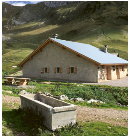
Bise, restaurant « chalet carré » avant rénovation
