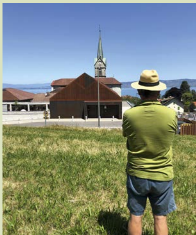
Extension du groupe scolaire à Lugrin, O-S Architectes
