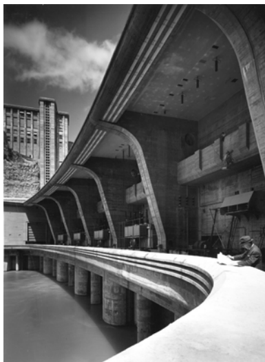
Barrage-usine de Génissiat © H. Lacheroy
