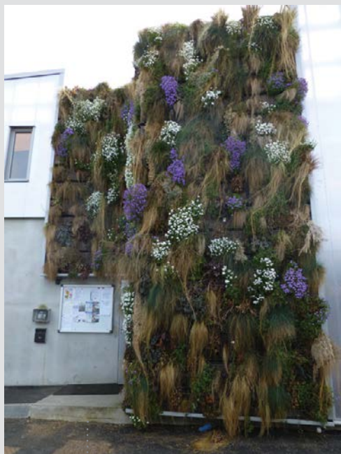
Labellisés Haute qualité environnementale, les nouveaux bureaux du service Parcs, jardins et cadre de vie, sont couverts d'une toiture et d'un mur végétalisés.
