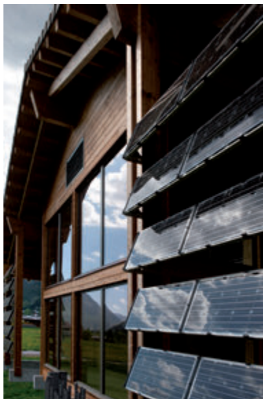
1 - Capteurs solaires photovoltaïques en façade
