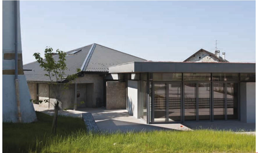
1 - La salle des fêtes réhabilitée et son extension
