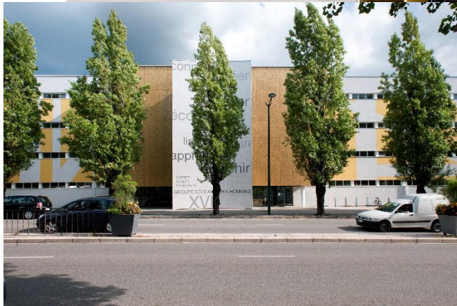
> Groupe scolaire et gymnase Les Romains (Réhabilitation), Annecy, 2018 Architecture : Vincent Rocques Architectes (VRA) © CAUE de Haute-Savoie / Béatrice Cafieri
