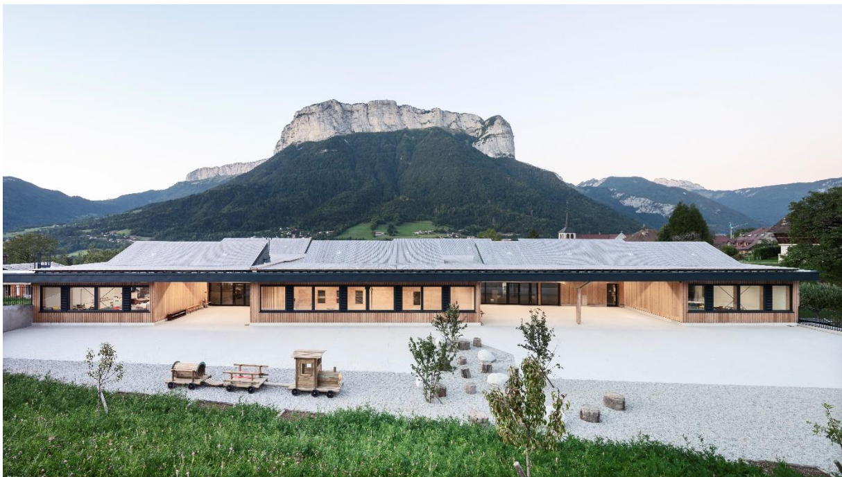
> Groupe scolaire et salle communale. Alex – 2019 / Nunc architectes © Luc Boegly
