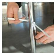
5/ insérer la tige filetée dans le portant et serrer (pas trop fort) en veillant à l'horizontalité et au parallélisme
