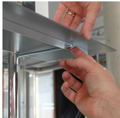
8/ positionner la plaque de dibon et visser avec un écrou
