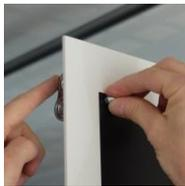
6/ positionner le panneau pvc sur le montant horizontal, visser avec un écrou chapeau
