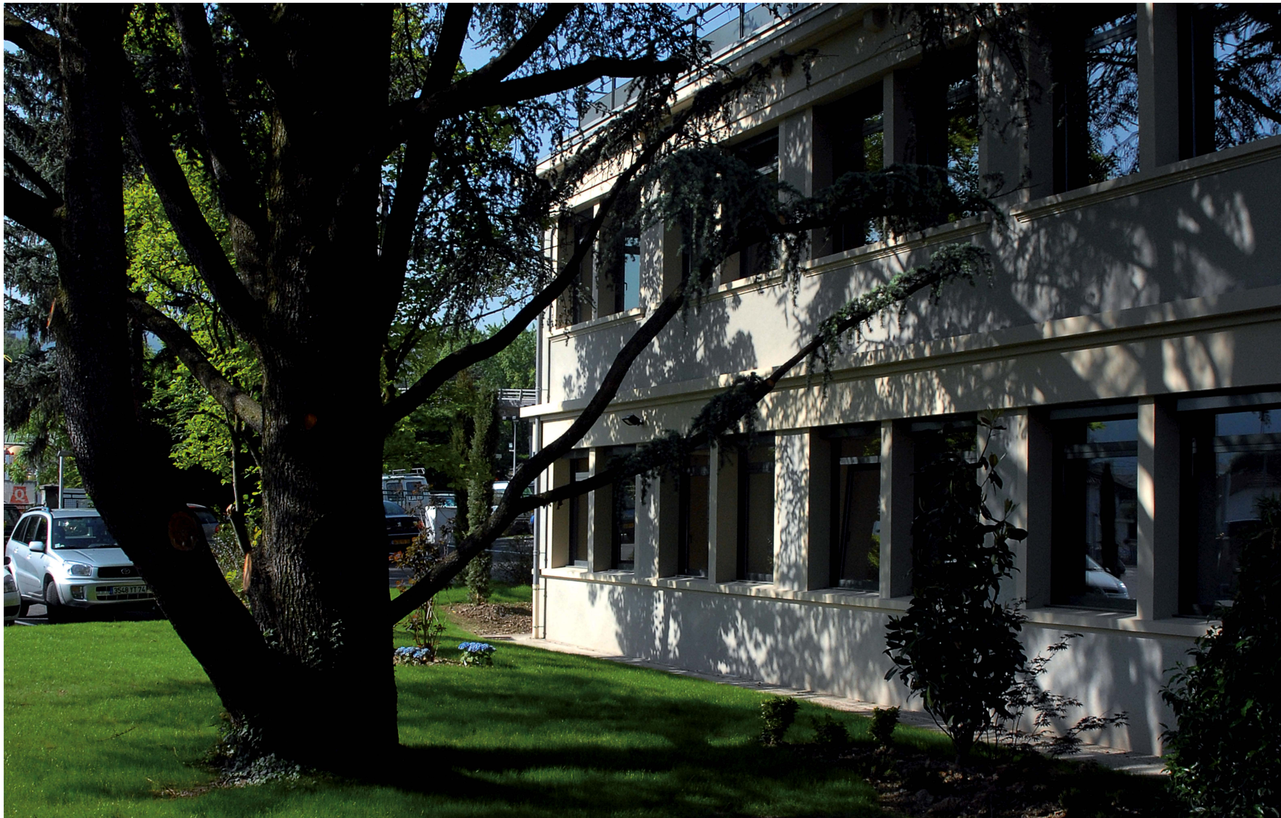
Les enduits et les peintures ont été repris sur les maçonneries afin de maintenir les façades dans leur conception d'origine. Les ouvertures ont été modernisées et ont reçu une protection avec des brise-soleil orientables.
