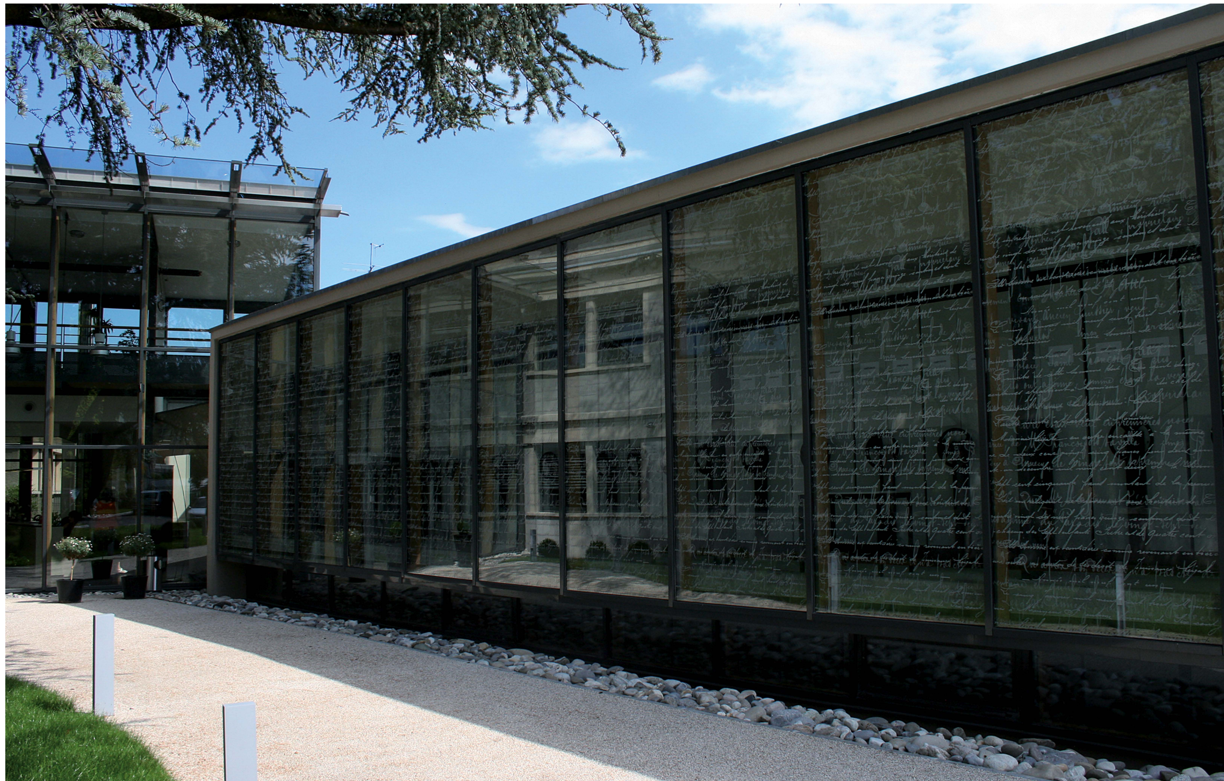
Les archives sont visibles à travers la double peau vitrée qui a reçu une sérigraphie sur le thème de la mémoire et du temps. Elle filtre la vue vers l'intérieur sur les meubles de stockage qui protègent les documents de l'ensoleillement direct.
