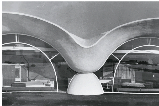
Ce magasin de mobilier immaculé, unique et communiquant, est édifié à Châtillon-en-Michaille en 1971. Il constitue un défi lancé aux volumes ternes des enseignes commerciales de la grande distribution qui commencent à fleurir. Transit constitue la plus grande réalisation de l'architecte en voile de béton coffré. © Fonds Chanéac / Archives départementales de la Savoie
