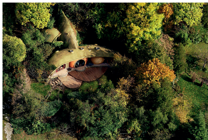
Bien que partiellement visible depuis la rue qui la domine et depuis la voie ferrée qui longe la partie basse du terrain, la maison est encastree dans son site pentu et boisé. © Nelly Chanéac, Jacques-Olivier Chanéac / Archives privées
