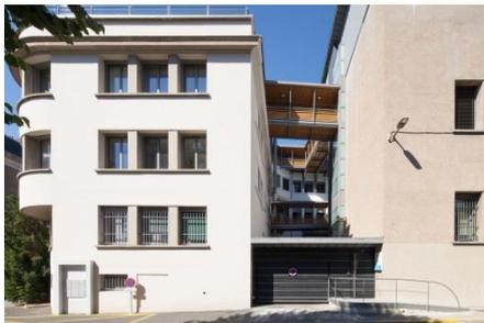
La Poste du Puy-en-Velay a été reconvertie en bureaux et logements. Les architectes ont créé de nouvelles circulations en greffant des passerelles sur le bâtiment d'origine. Ces passages deviennent un élément clé et central de cette reconversion architecturale, jouant sur les notions de pleins et de vides. Le vide entre les îlots est animé par les pleins : les passerelles.
