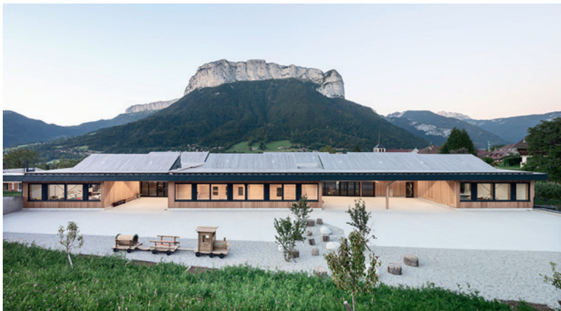
Groupe scolaire et salle communale, Alex - 2019 / Nunc architectes © Luc Boegly
