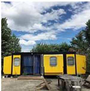
Exemple : le tétrodon, construction modulaire – Atelier d'urbanisme et d'architecture (Jacques Berce et Henri Ciriani) – années 1970. Les coques sont en polyester
